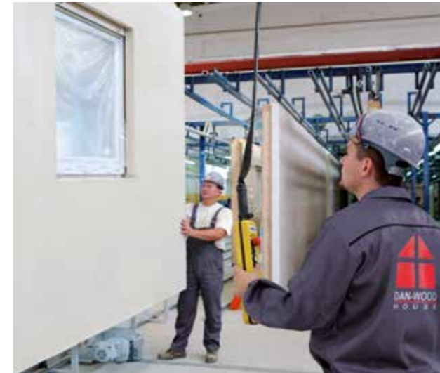
Die Wände werden in der Fabrik vorgefertigt...
