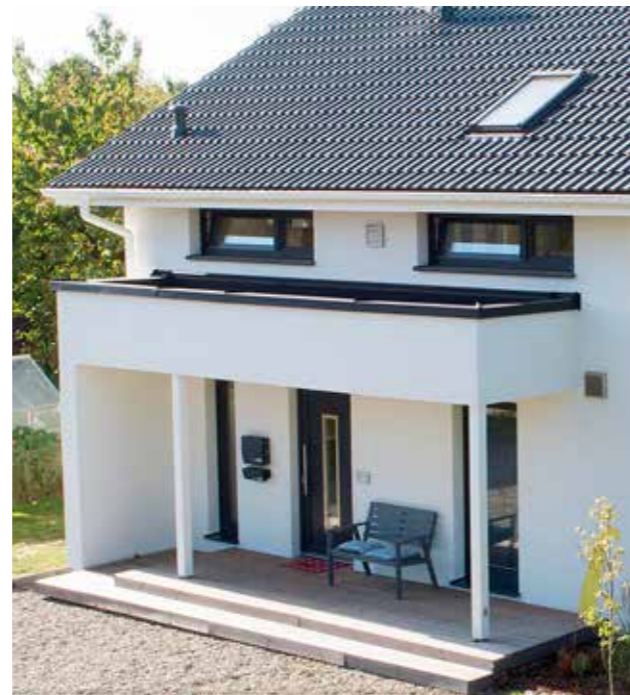
Moderne Flachdachversion einer Eingangsüberdachung
