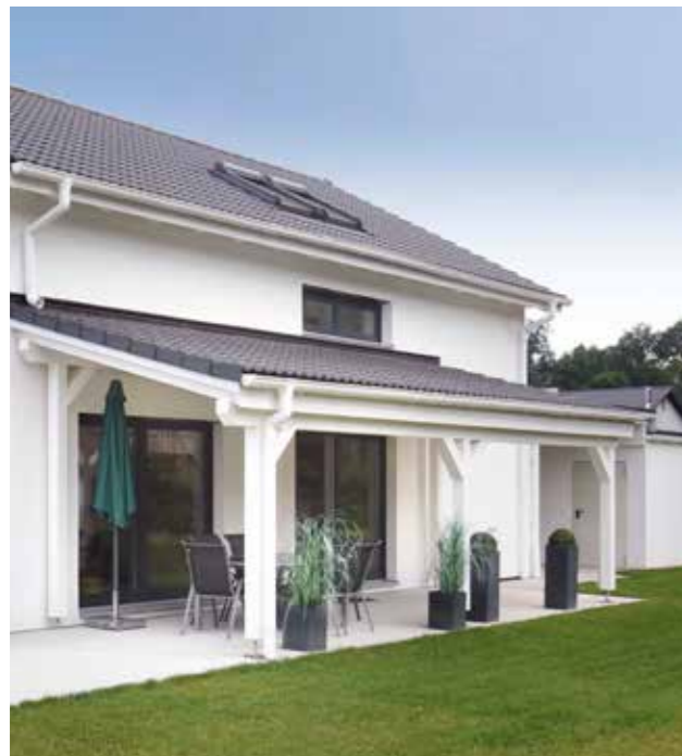
Solides Dach über der Terrasse
