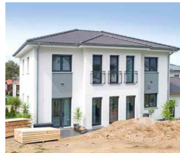
Nach ca. 12 Wochen ist die Villa fertig...
